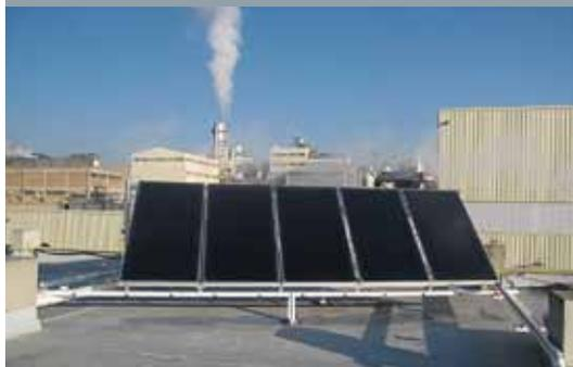
試験プロジェクト: スペインのセピリアとモントルネスの事業所内に小型太陽熱発電システムを設置しました(写真)。このシステムは日射熱を利用して事業所に温水を供給します。
